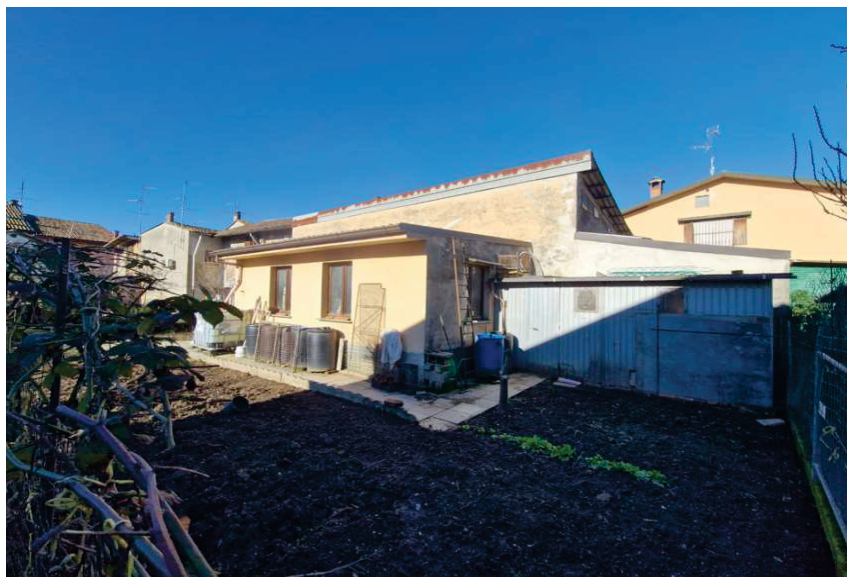
12 - Deposito con area pertinenziale
