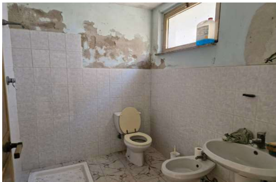
9 - bagno interno al rustico
