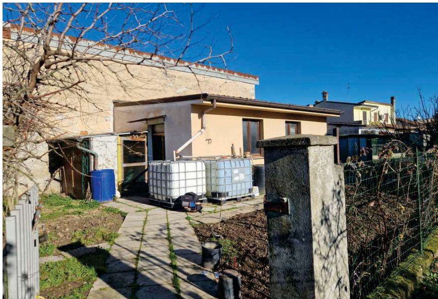
11 - Deposito con area pertinenziale
